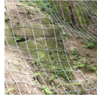
» ワイヤネット 岩塊の滑動をアンカーとワイヤロープで抑制する落石予防工です。
