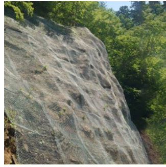
● J-ワイド伏工 高強度金網を用いることで省力化・高耐久を実現した落石予防工です。
