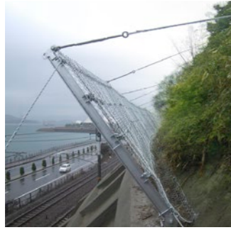
» J-キャフネット あらゆる斜面に設置可能で、コンクリート基礎不要の落石防護工です。
