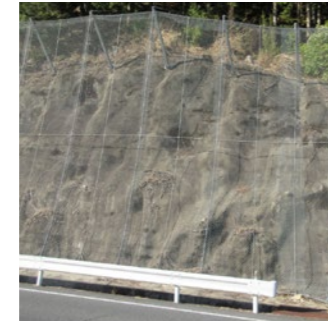
» JFE落石防護網 誘導・待受け型の落石対策工です。
