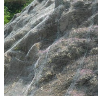
» JSグリップネット 斜面上の浮石・転石の動きを抑制する落石予防工です。
