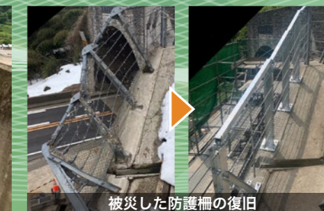
被災した防護柵の復旧
