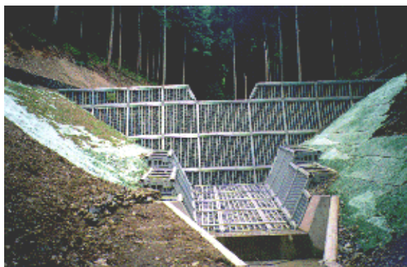
施工例 - 4 京都府（堤高：6 m）
