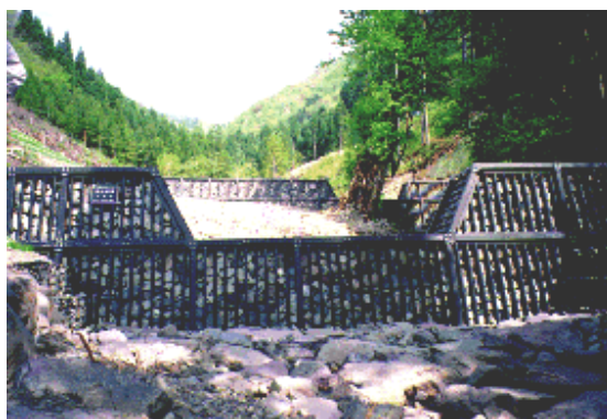
施工例 - 3 兵庫県（堤高：4.5 m）
