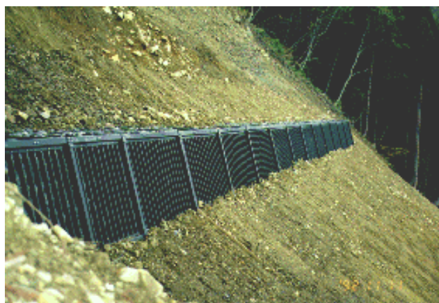
施工例 - 2 兵庫県（堤高：4 m）
