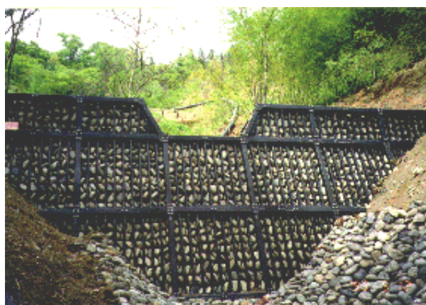
施工例 - 1 長野県（堤高：6 m）
