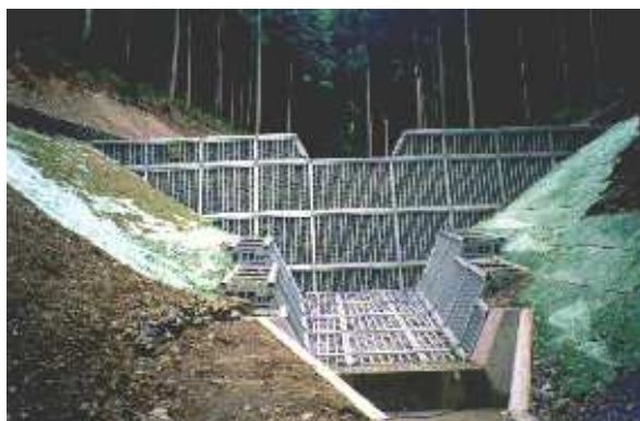
施工例－4 京都府（堤高：6 m）
