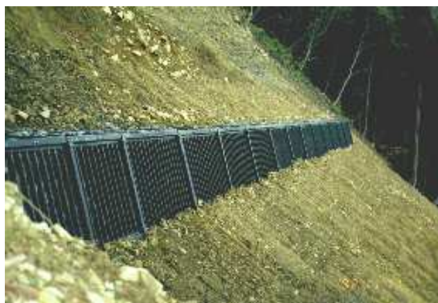
施工例－2 続枠（旧タイプ）擁壁
