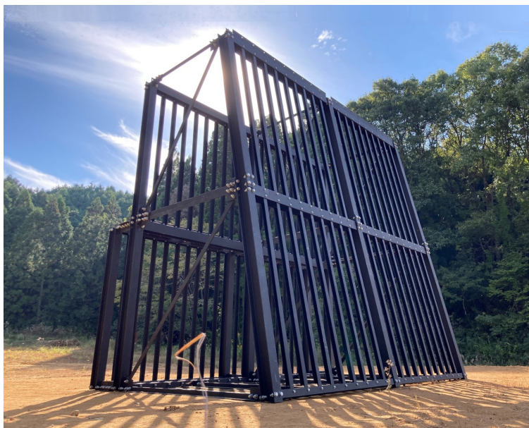
試験施工 (H4.0m×L4.0m)
