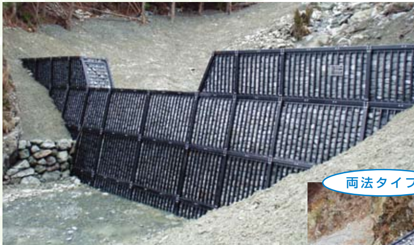
三好市西山治山ダム工事(徳島県) 堤高 6m
