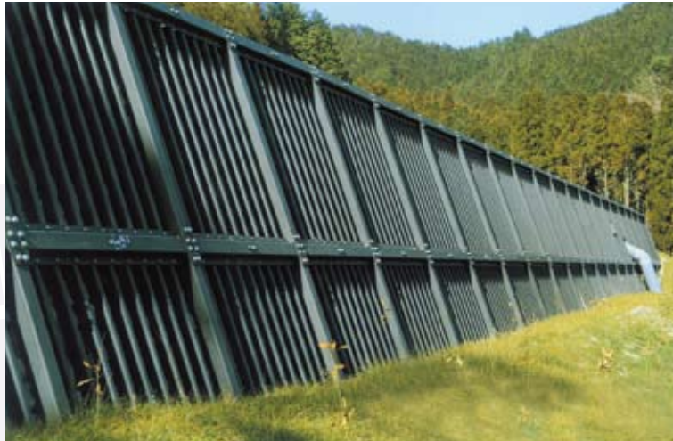
小原地区復旧治山工事（佐賀県） 堤高 4m
