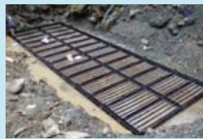
底面部の仮組み・本締め
