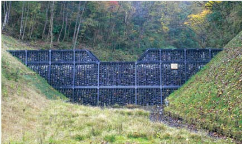
水源流域地域保全事業(京都府) 堤高 6m
