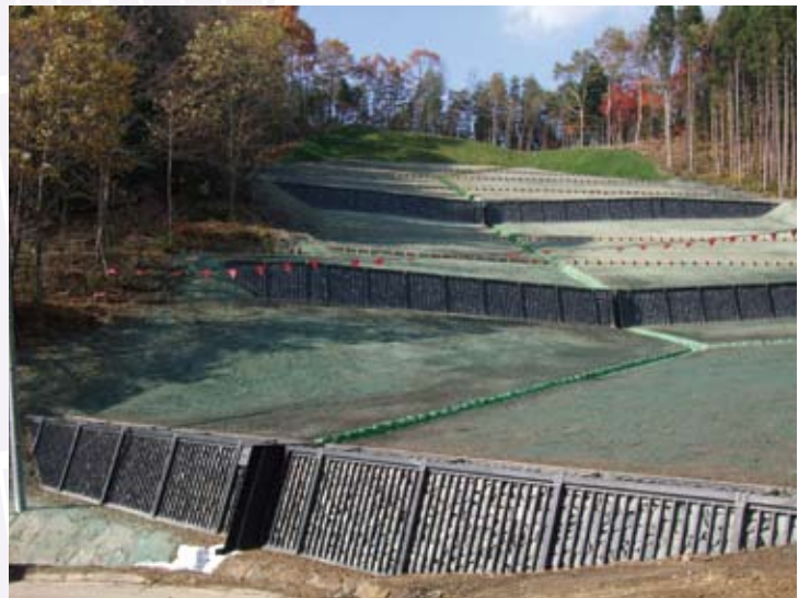
上沼災害関連緊急治山工事（宮城県） 堤高 3m
