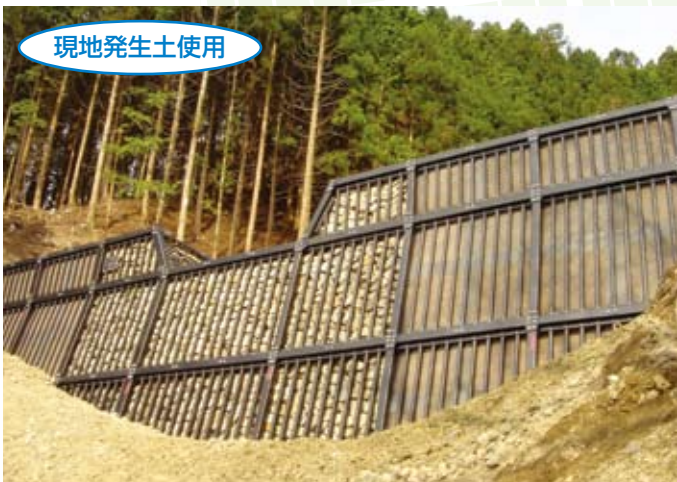
復旧地山 神山町三ツ木谷止工(徳島県) 堤高 6m
