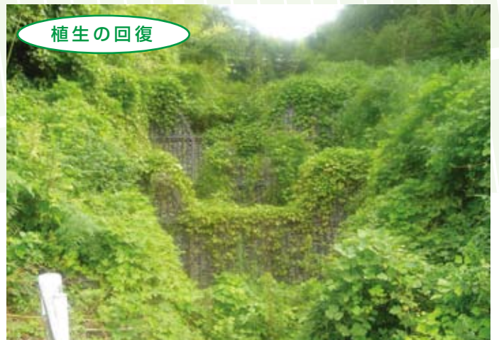
尾山地すべり防止工事 (徳島県) 堤高 5m
