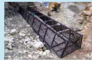
上層部の仮組み・本締め
