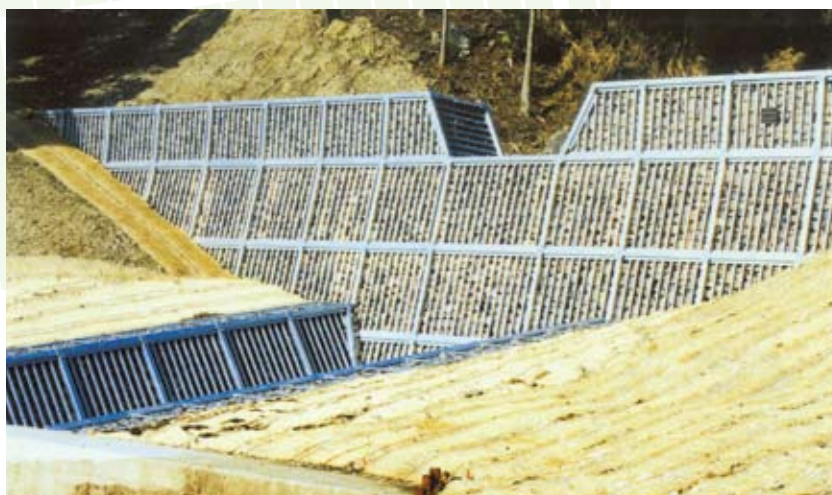
水源地域緊急整備事業 (佐賀県) 堤高 6m
