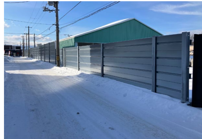
設置状況 (敷地外側)
