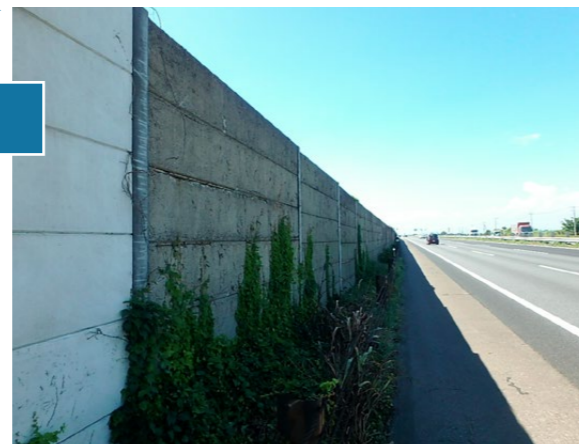
更新前のコンクリート遮音板
