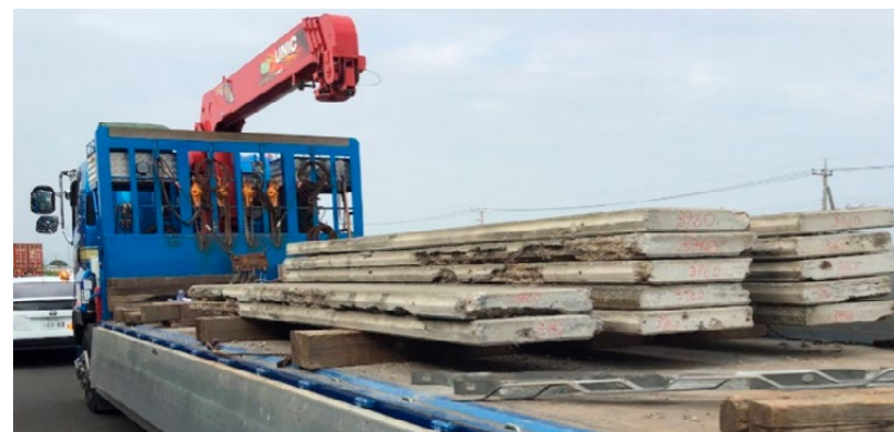
撤去したコンクリート製遮音板
