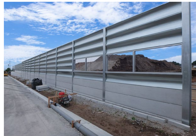
施設出入口は透光板と合わせ視認性を確保
