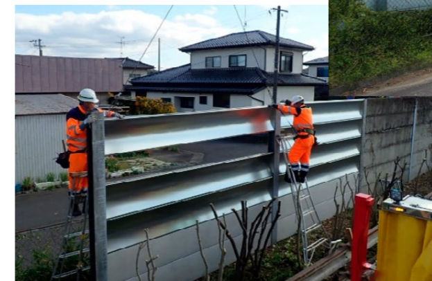
Rモード施工状況
