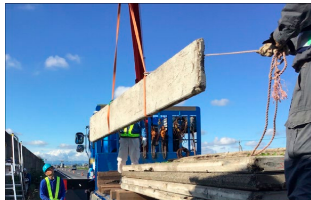
コンクリート遮音板 撤去作業
