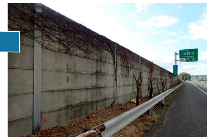
更新前のコンクリート遮音板
