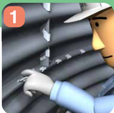
1 Jスピードクリップを差し込みます
