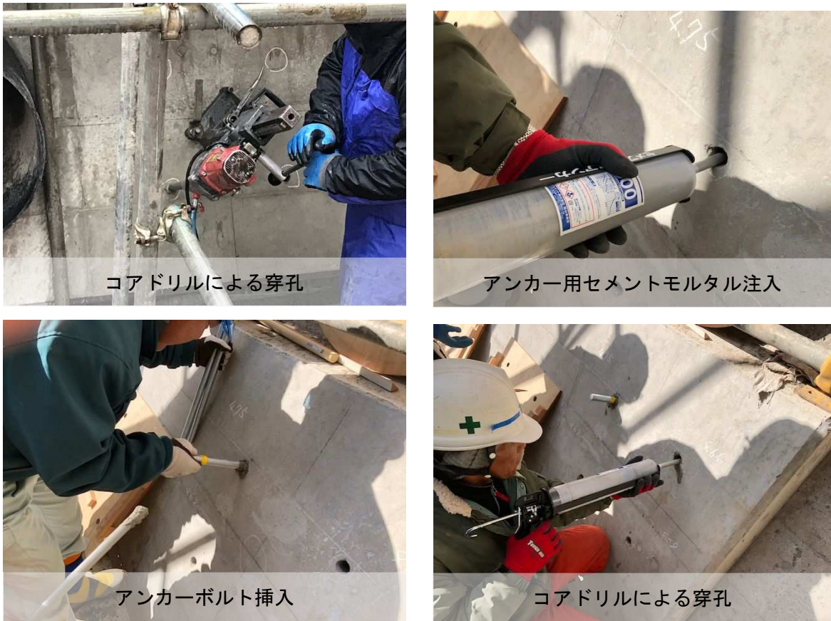
図 8 アンカーボルト設置（上流側法面部）
