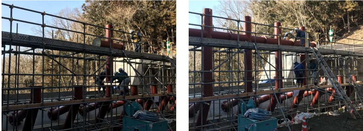
図 11 上段フレーム組立状況
