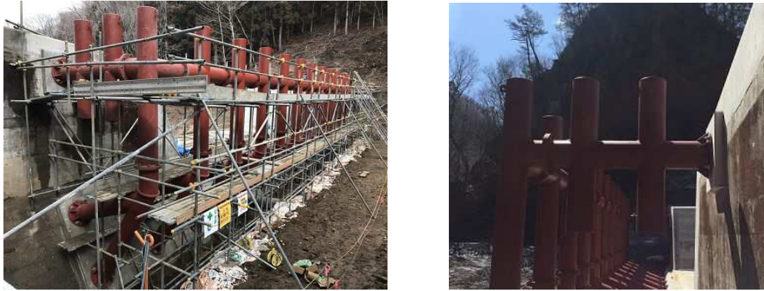
図 13 側面フレーム取付完了状況
