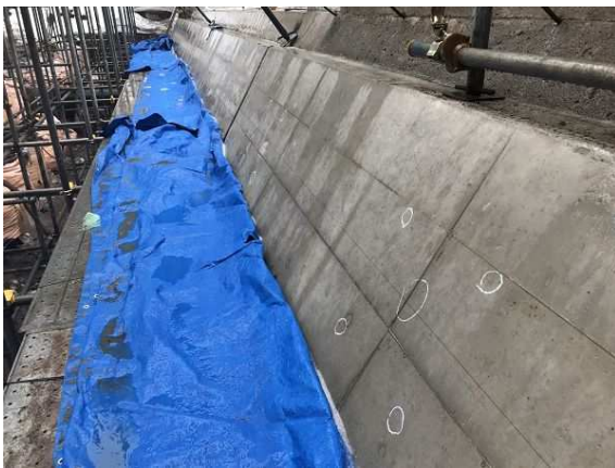
図 7 アンカーボルト位置出し
