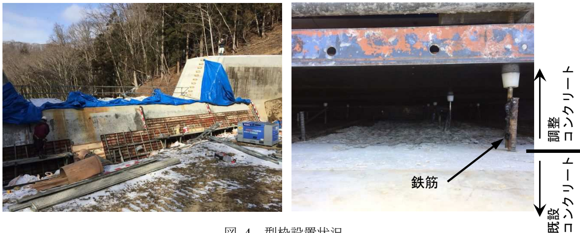
図 4 型枠設置状況
