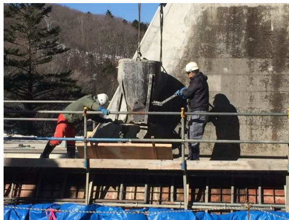
図 5 コンクリート打設状況
