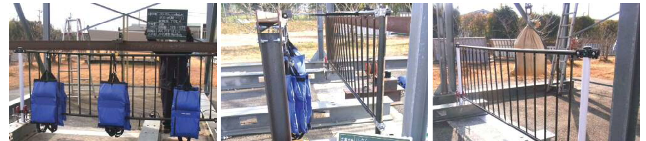
載荷実験状況（鉛直：590N/m）
