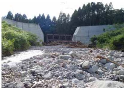
《J-スリット堰堤》土石流捕捉
