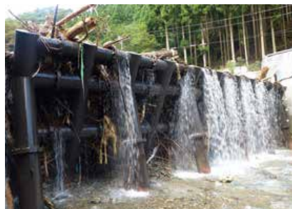
《J-スリット堰堤》土石流捕捉
