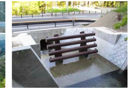
JD フェンスによる保護工設置例
