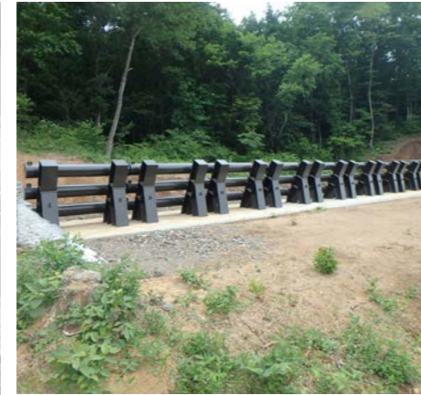
■ 施工場所 福島県 ■ 設置延長 36.0m ■ 鋼製高 2.0m
