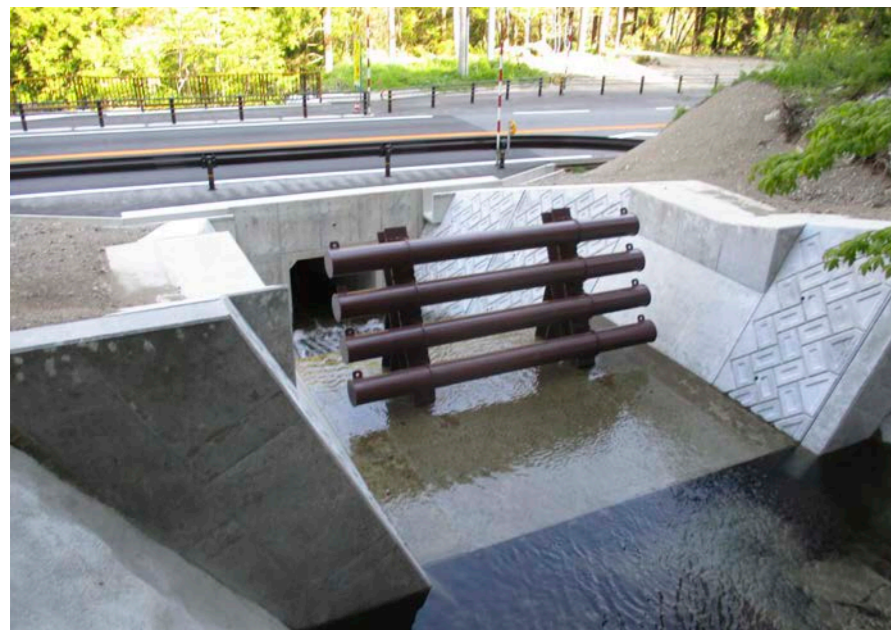
■ 施工場所 岐阜県 ■ 設置延長 4.5m ■ 鋼製高 2.0m
