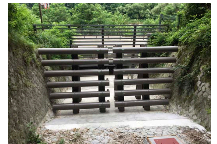
■ 施工場所 長野県 ■ 設置延長 8.6m ■ 鋼製高 4.5m
