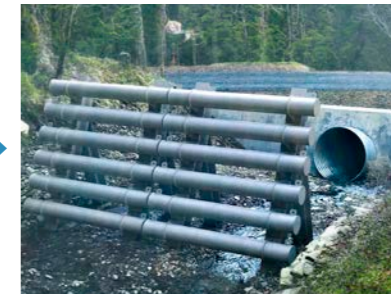
JD フェンスによる保護工設置例
