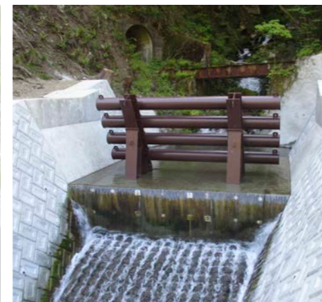
■ 施工場所 岐阜県 ■ 設置延長 4.5m ■ 鋼製高 2.0m
