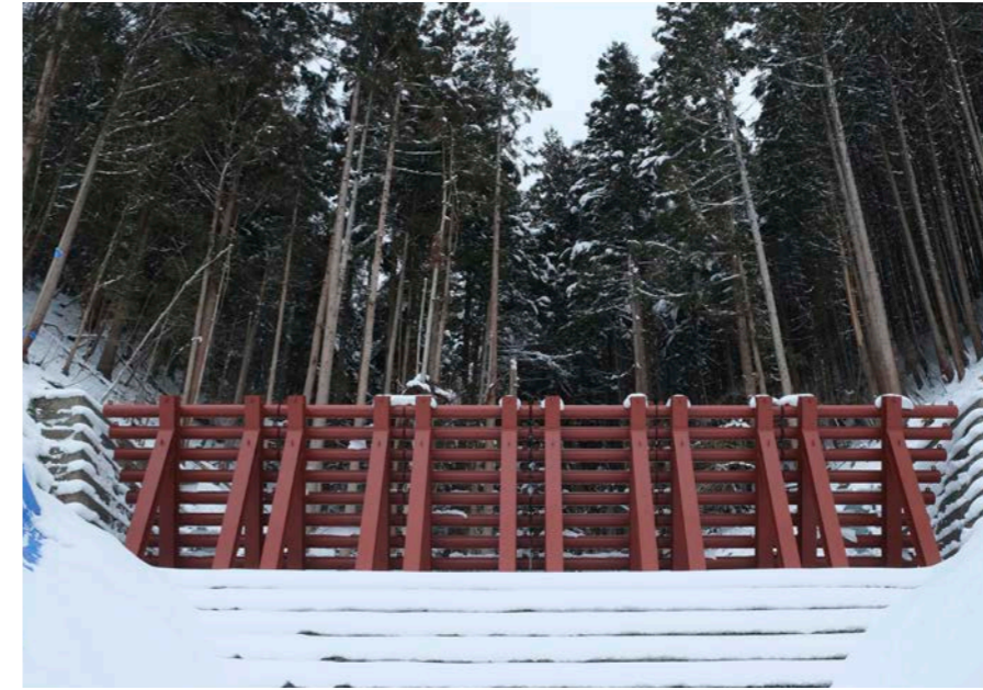
■ 施工場所 広島県 ■ 設置延長 18.0m ■ 鋼製高 5.0m
