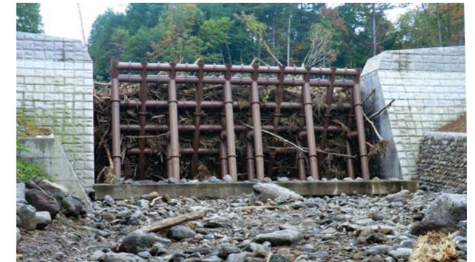
■ 施工場所 岩手県 ■ 有効高 8.0m ■ 水通幅 20.0m
