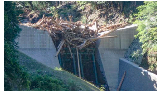
■ 施工場所 兵庫県 ■ 有効高 6.7m ■ 水通幅 10.0m
