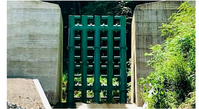
■ 施工場所 高知県 ■ 有効高 6.5m ■ 水通幅 5.0m
