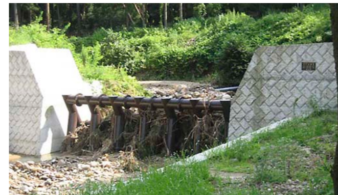
■ 施工場所 富山県 ■ 有効高 3.0m ■ 水通幅 9.0m
