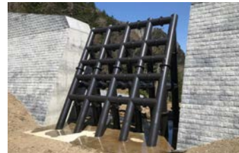
■ 施工場所 北海道 ■ 有効高 8.0m ■ 水通幅 10.0m
