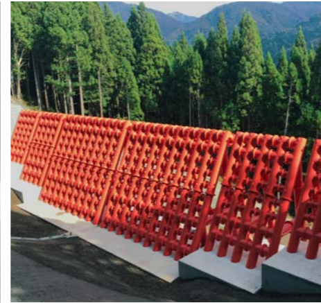
■ 施工場所 長野県 ■ 有効高 6.0m~9.0m ■ 水通幅 40.0m
