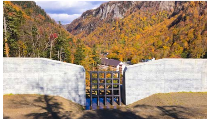
■ 施工場所 北海道 ■ 有効高 8.0m ■ 水通幅 10.0m
