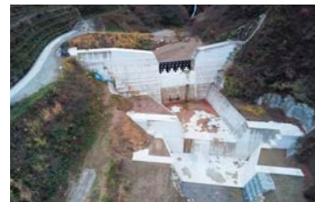
■ 施工場所 新潟県 ■ 有効高 3.5m ■ 水通幅 11.5m
