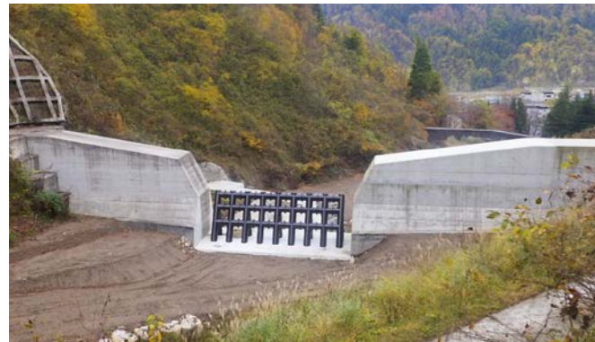
■ 施工場所 新潟県 ■ 有効高 3.5m ■ 水通幅 11.5m
