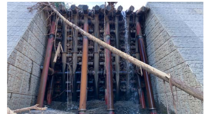
■ 施工場所 福岡県 ■ 有効高 10.5m ■ 水通幅 10.0m
