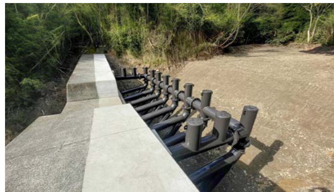
■ 施工場所 静岡県 ■ 有効高 1.5m ■ 水通幅 4.0m
