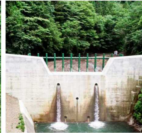
■ 施工場所 群馬県 ■ 有効高 4.0m ■ 水通幅 12.0m
