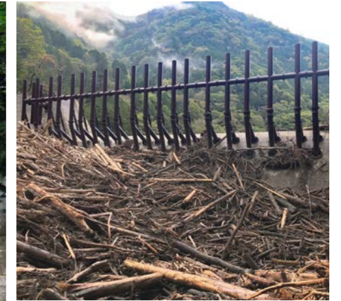
■ 施工場所 長野県 ■ 有効高 6.0m ■ 水通幅 26.0m
