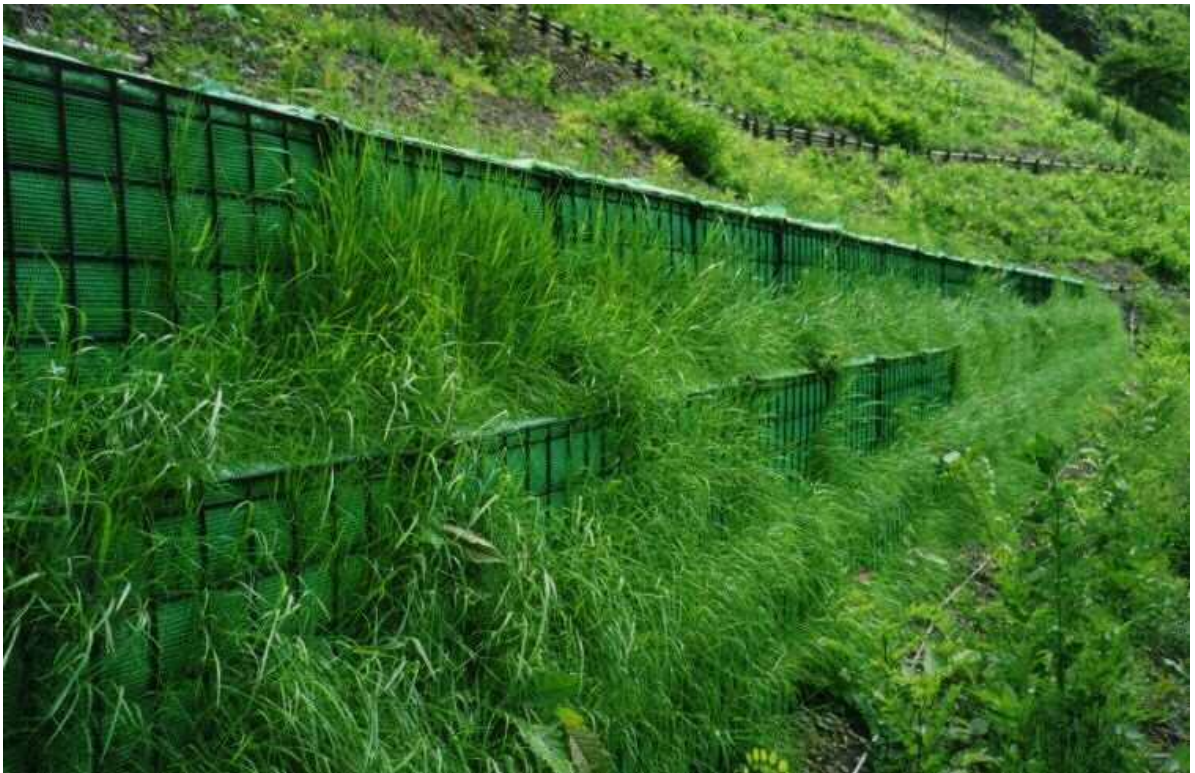
植生シートにより緑化された J F E 籠枠 (Mパッケージ)
