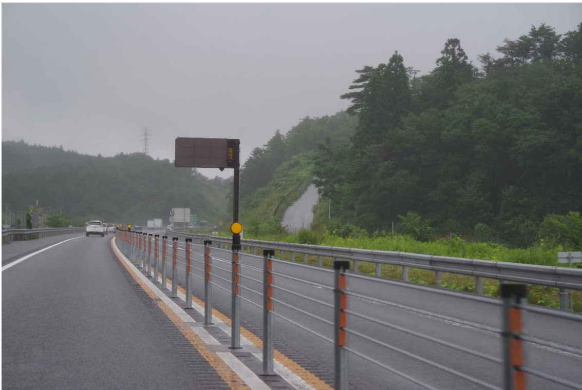
『J ピカオレンジ反射スペーサーを取り付けた状態の施工途中写真』(昼間)
