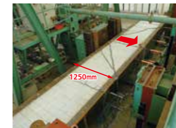
鋼コンクリート合成構造の確認 (つなぎ材合成効果検証)
