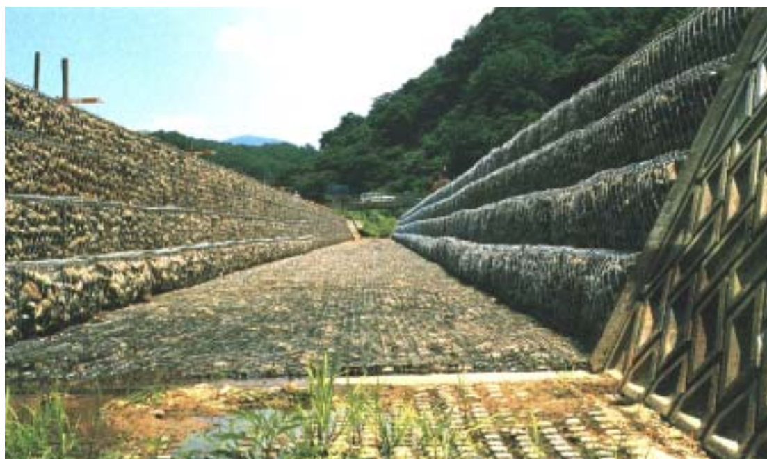
施工例 - 2 新潟県
