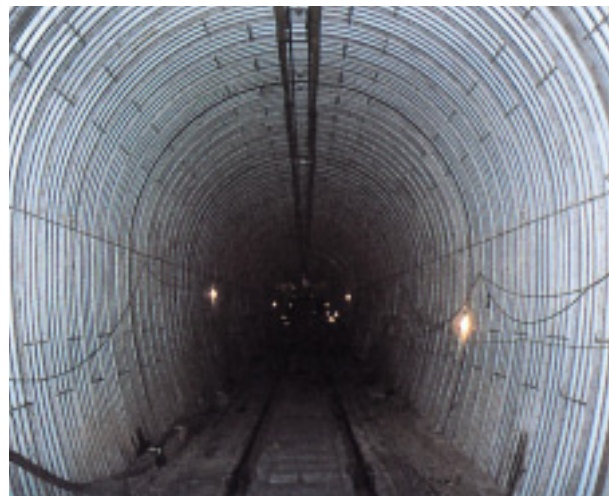
トンネル(馬蹄形アーチ)
